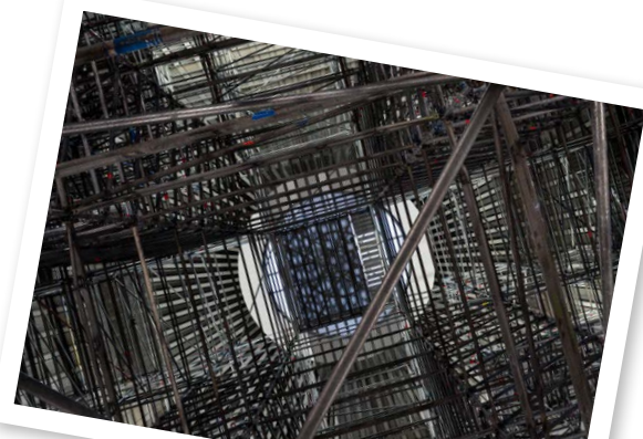
August 2022: Die Kathedrale ist innen bis zum Opaion hinauf eingerüstet
