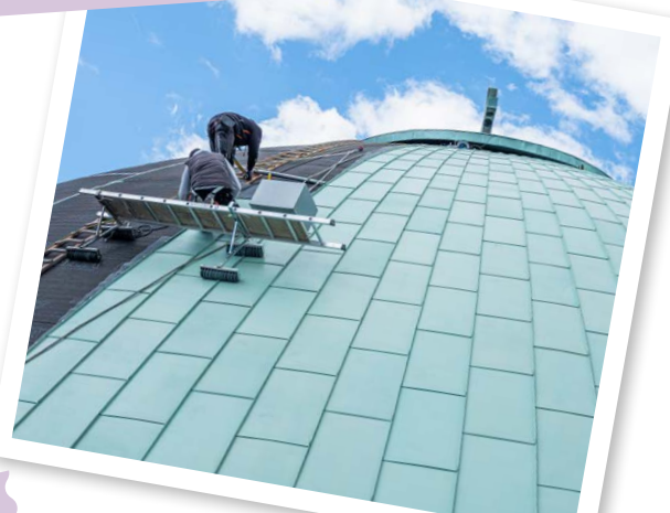
April 2021: Letzte Arbeiten an der Kuppel
