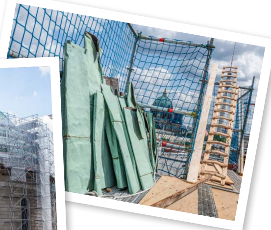
Ab Juli 2020: Die Dächer werden komplett saniert und mit neuen Kupferplatten im bisherigen Grünnton neu eingedeckt
