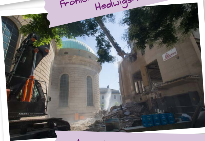
August 2022: Das 70er-Jahre-Gebäude des Bernhard-Lichtenberg-Hauses wird abgerissen
